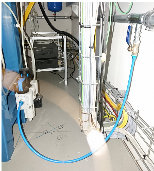
Fot. 1. Połączenie pomiędzy przyłączem na magistrali szkieletowej a rozdzielaczem zasilania
